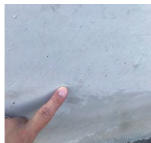
下地清掃・凹凸確認
