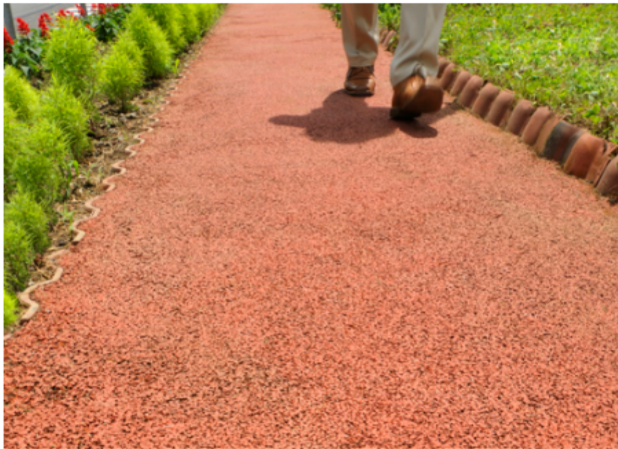
瓦の廃材を再利用した低蓄熱性舗装材『エコストラダ』を新発売しました。
