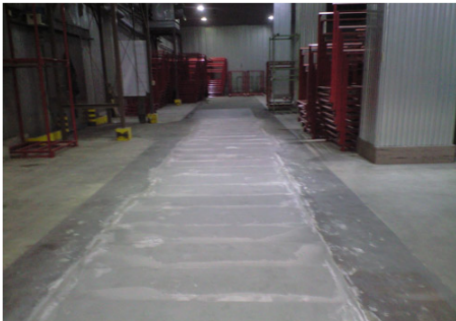
冷凍倉庫内補修例
