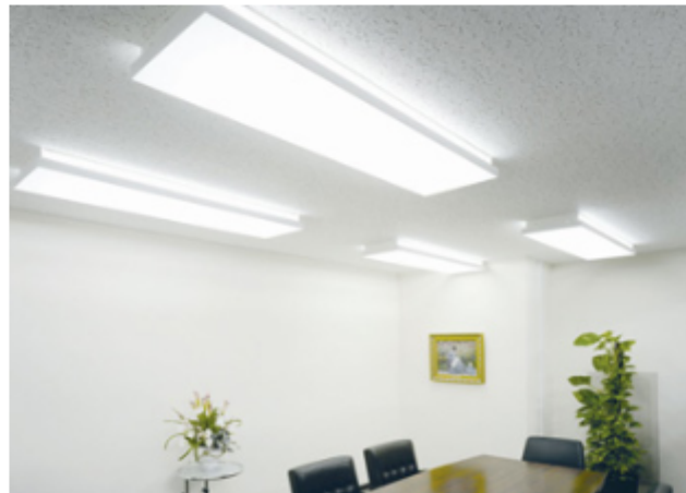
施工後（天井面が明るく、快適な環境になった）
