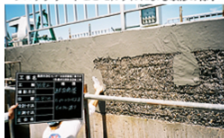
プロテクリートGSモルタルによる改修の様子
