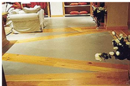
木素材との組合せ施工例
