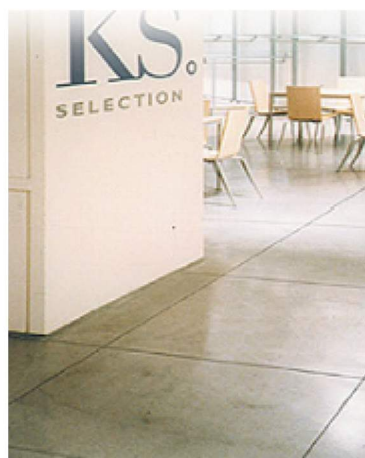
目地カット施工例
