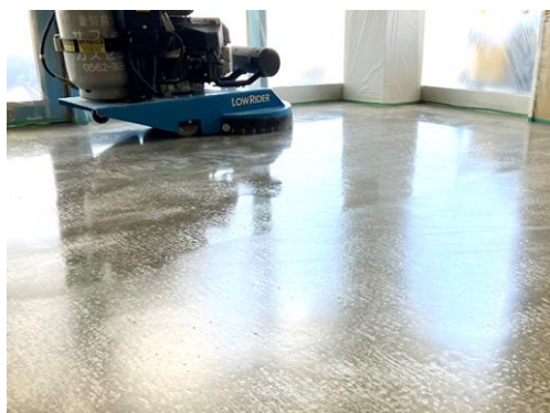
手前:バフイング前 奥:バフイング後
