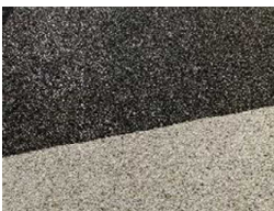
コンクリート下地に天然石を用いた樹脂モルタルを施工
