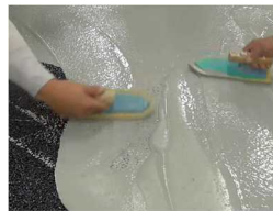
目詰め材をゴムゴテで塗り伸ばし
