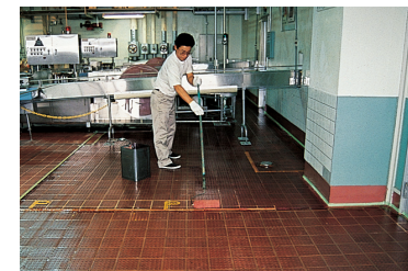
② ABC タイル面用プライマーの塗付
