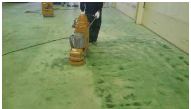
②床の下地処理
