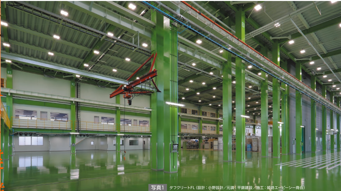
写真1 タフクリートFL（設計：小野設計／元請：平錦建設／施工：姫路エービーシー商会）
