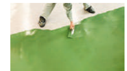
コテ押えが不要なため、従来の無機系床材と比較して施工が容易。工期短縮と施工費の軽減に繋がる。
