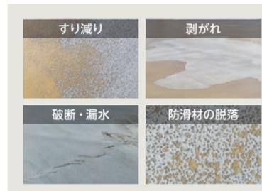
「特に床の負荷が大きい箇所は、車のハンドルの切るコーナー部分です。タイヤのきしむ音が気になるようなら、表面の防滑材が摩耗している証拠なので要注意。当社が施工した現場であればその後も定期的に点検に伺いますので、そこまで劣化が進行する前に適切な補修方法をご提案できます」(國本氏)。施工後もきめ細やかなアフターフォローでお付き合いを続けることにより、現場の信頼を獲得している。
