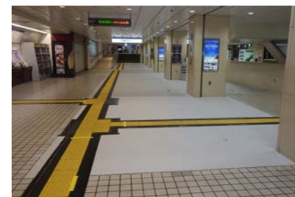
写真の白いところが、既存床の上に「ケミクリートMS・L #5414」で均した箇所。施工後1時間程度で硬化するので、始発の時間にはそのままの状態でも利用者に開放した
