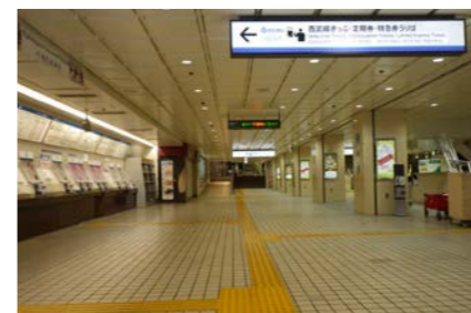
改修前の西武新宿駅コンコース。1977年に現在の駅が完成して以来、タイルの床だった
