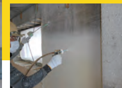
コンクリート面への直接吹付も
